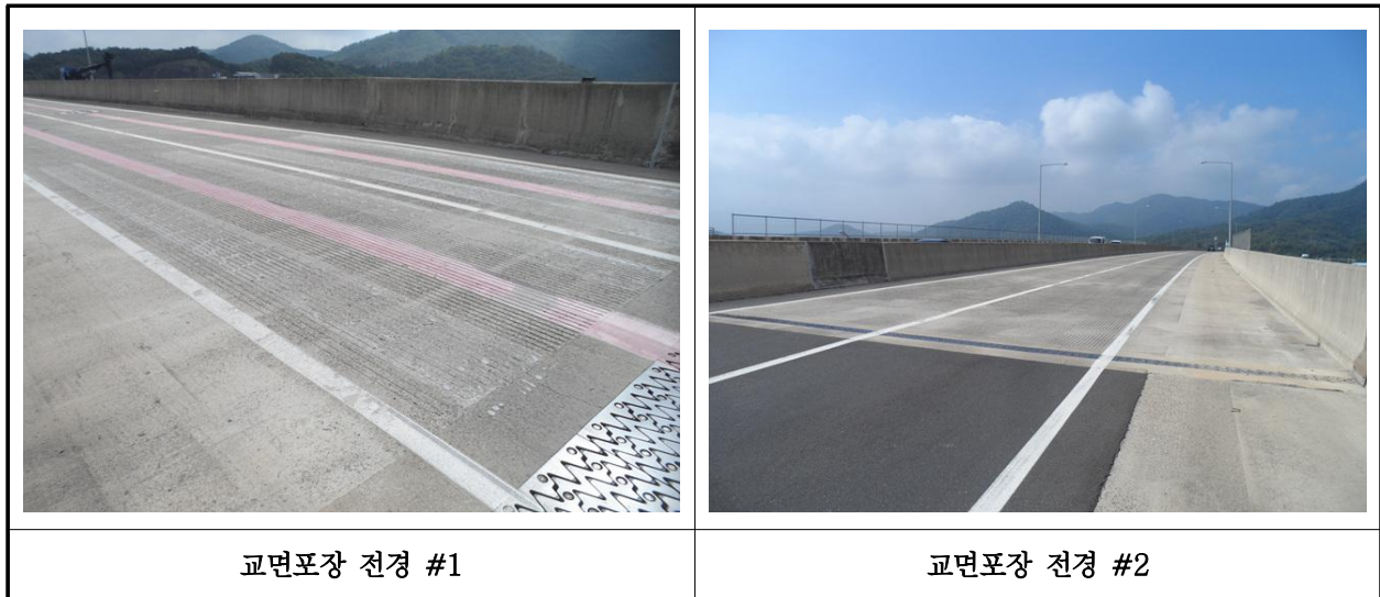
【사진 40.3.45】 교면포장 전경
