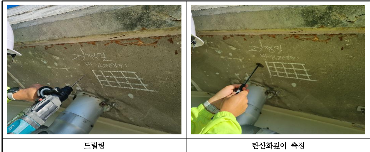
【사진 40.4.3】 탄산화 깊이 측정 현장사진
