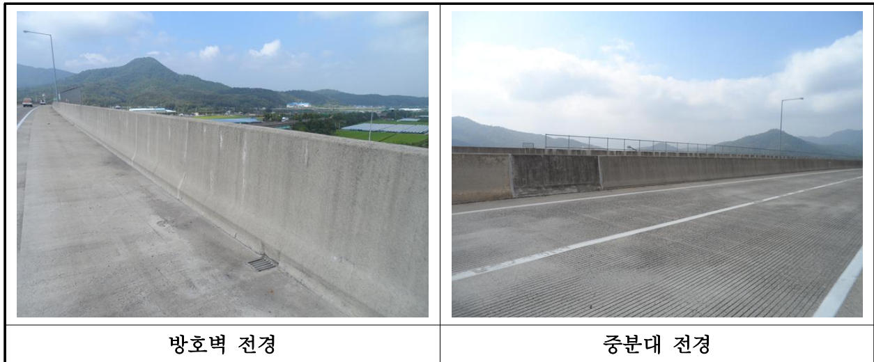
【사진 40.3.49】 방호벽 및 중분대 전경
