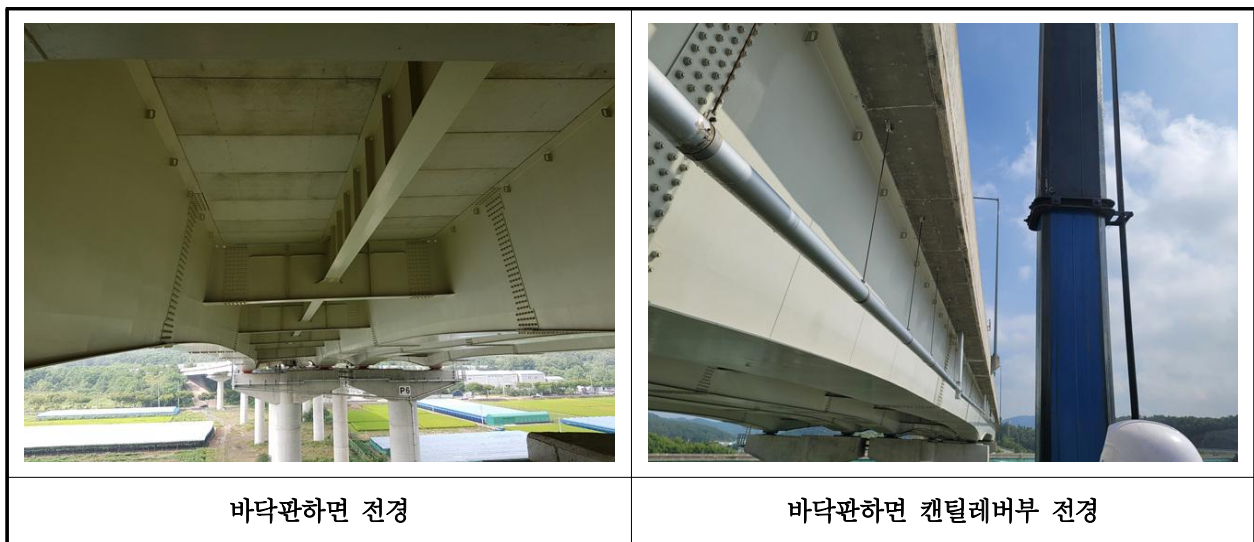
【사진 40.3.2】 바닥판하면 전경
