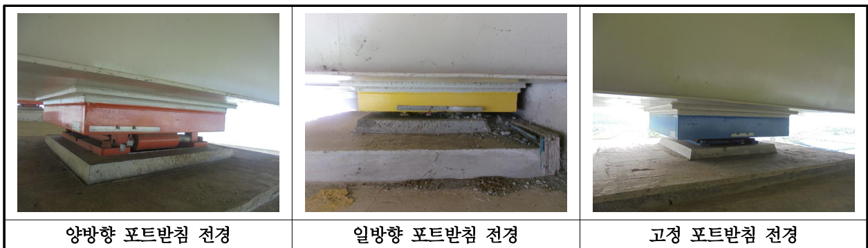
【사진 40.3.12】 교량받침 전경
