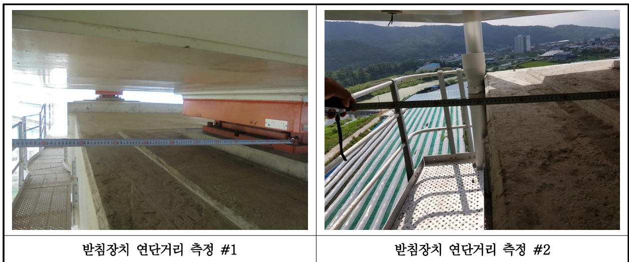
【사진 40.3.14】 교량받침장치 연단거리측정
