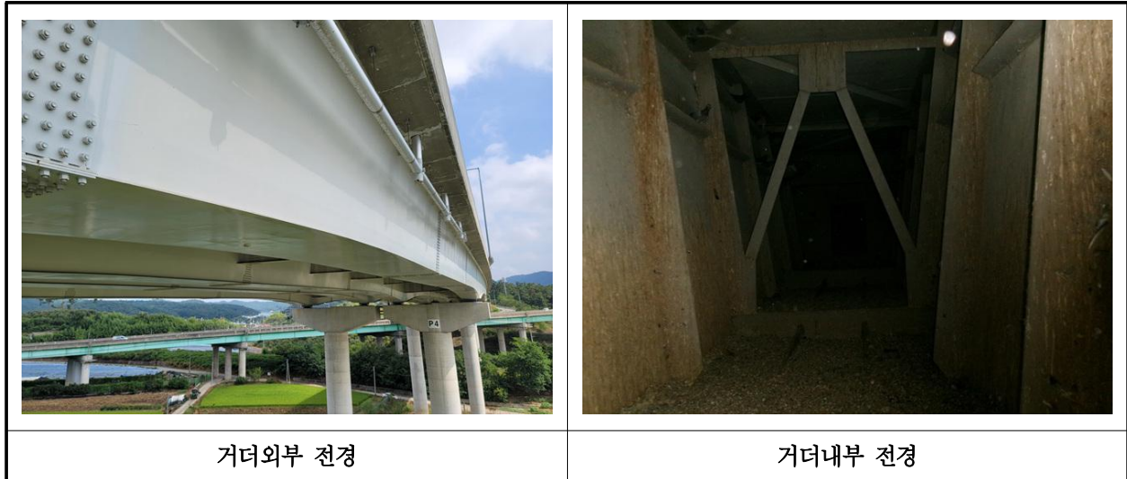
【사진 40.3.4】 거더 전경
