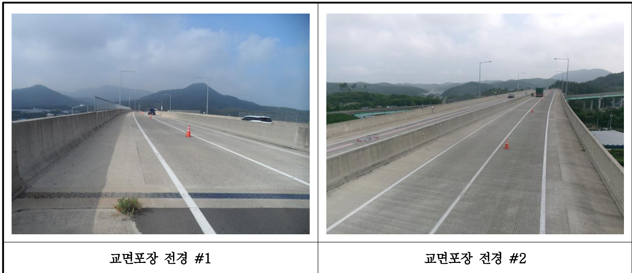
【사진 40.3.19】 교면포장 전경
