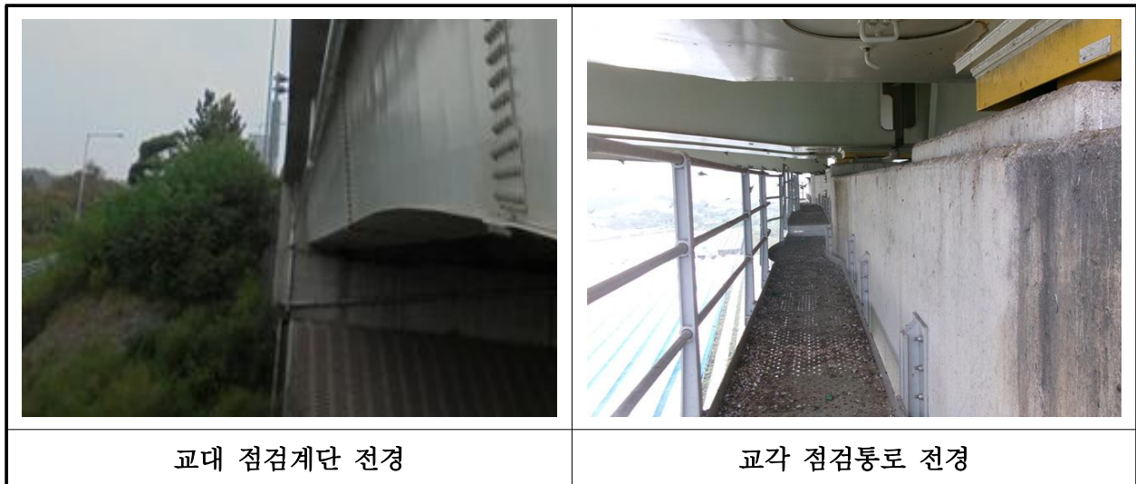
【사진 40.3.51】 교량 점검시설 전경
