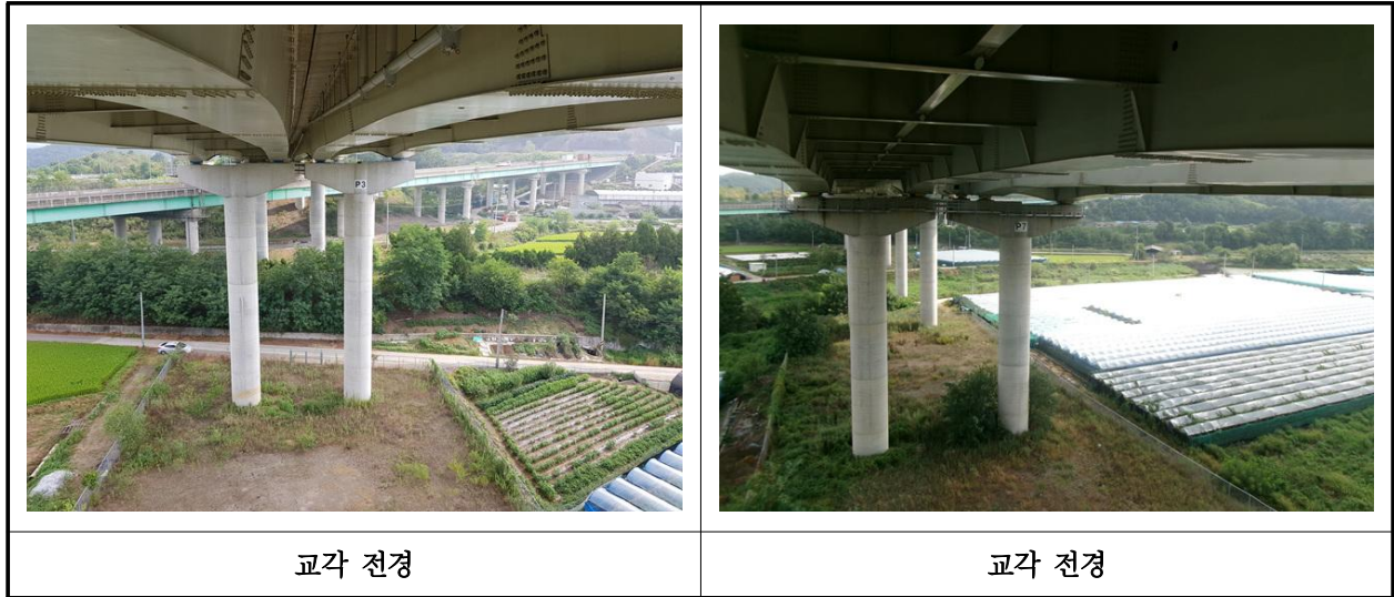
【사진 40.3.10】 교각 전경
