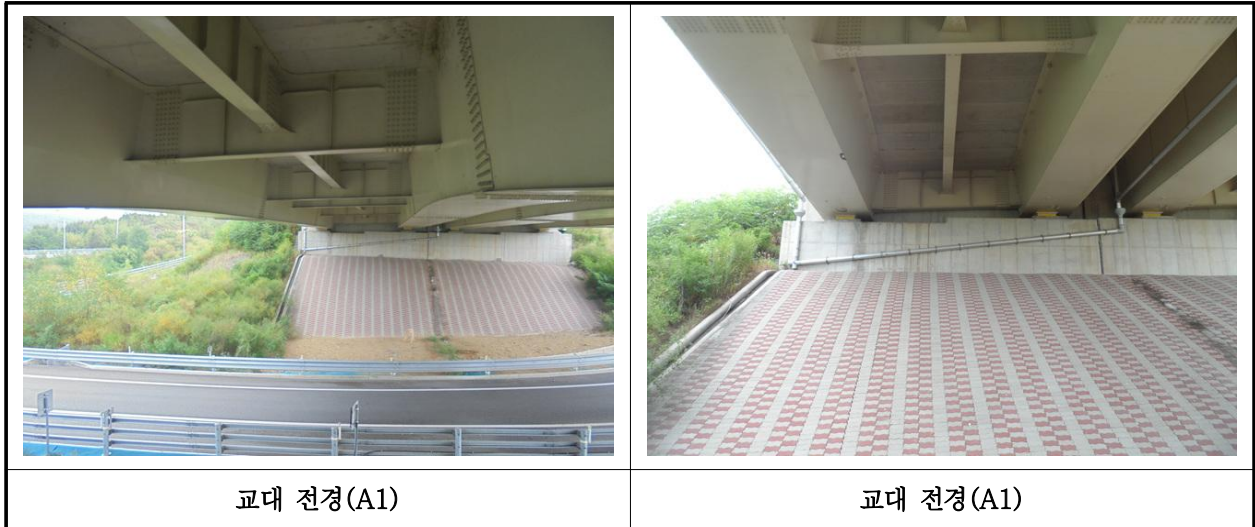
【사진 40.3.34】 교대 전경
