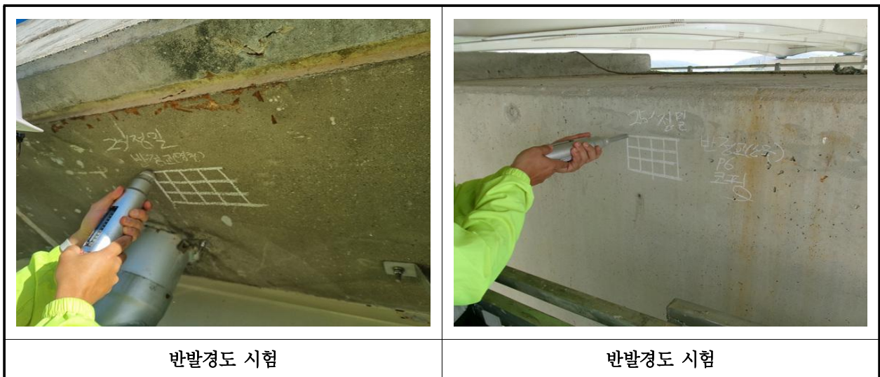
【사진 40.4.2】 반발경도시험 현장사진
