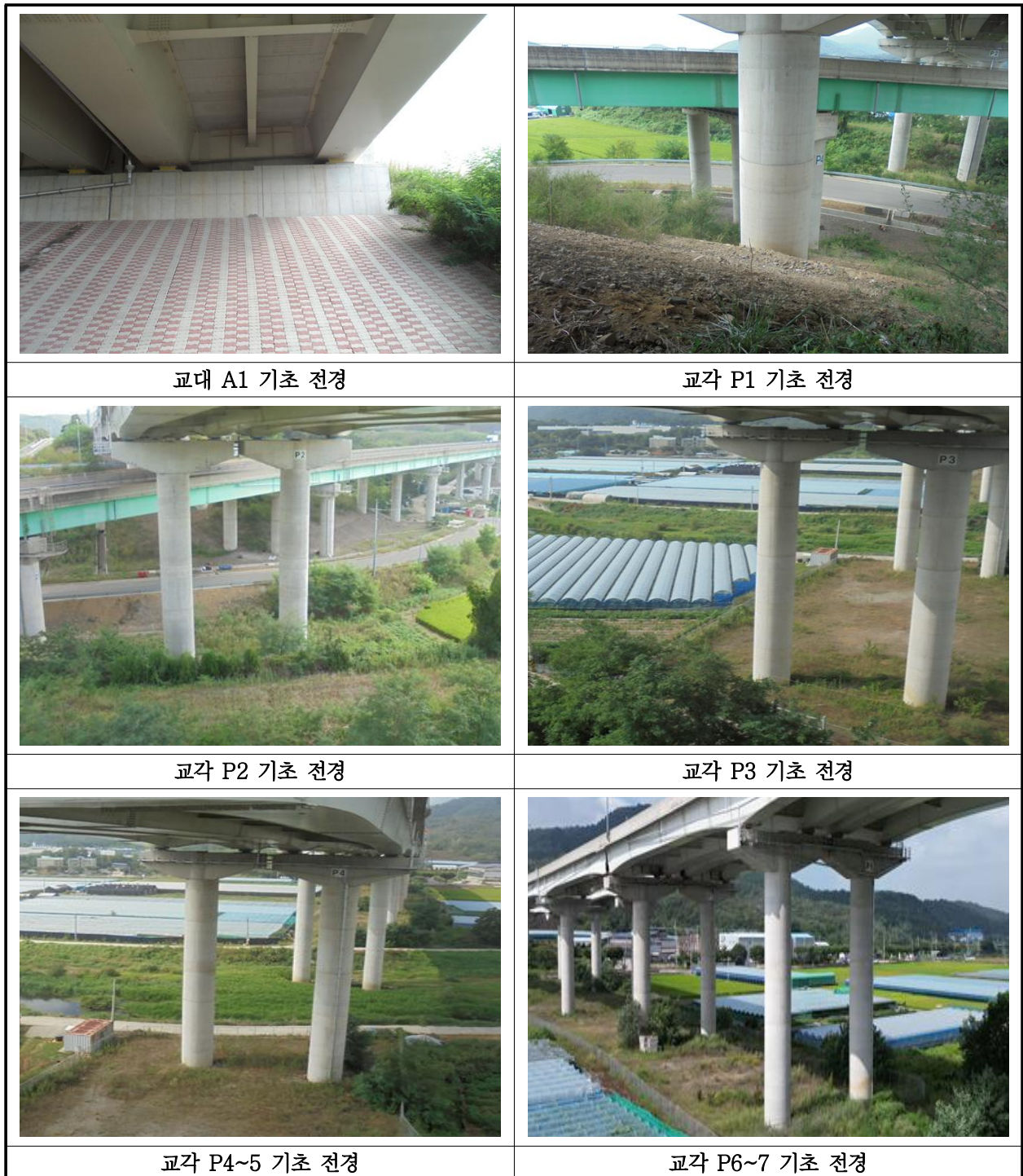
【사진 40.3.12】 기초 전경
