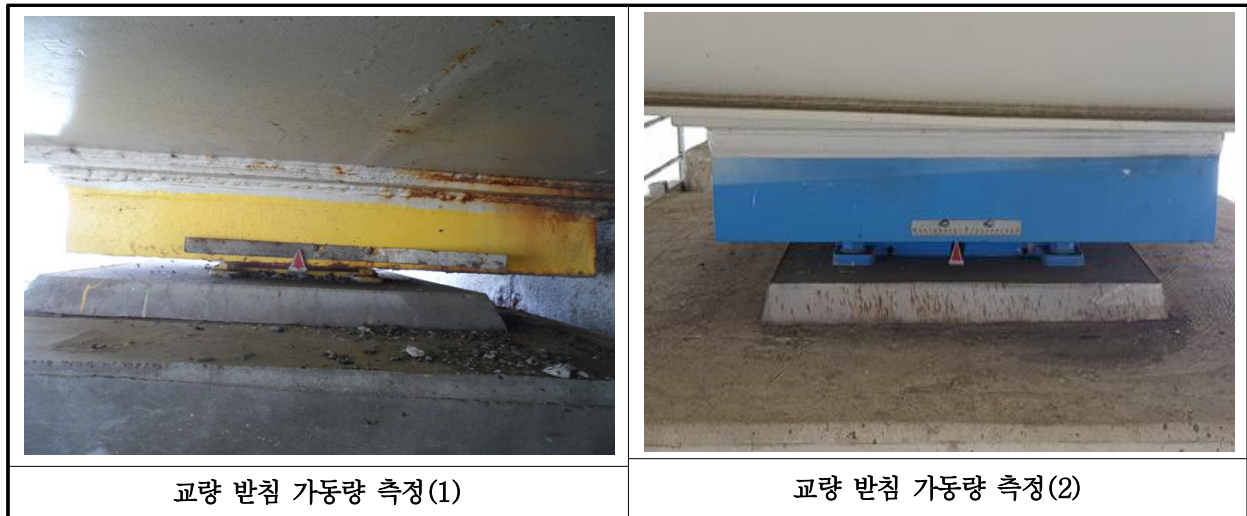
【사진 40.3.41】 교량받침 이동량 측정
