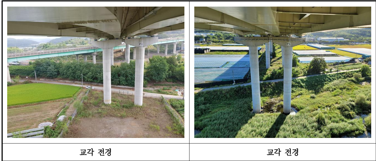
【사진 40.3.36】 교각 전경
