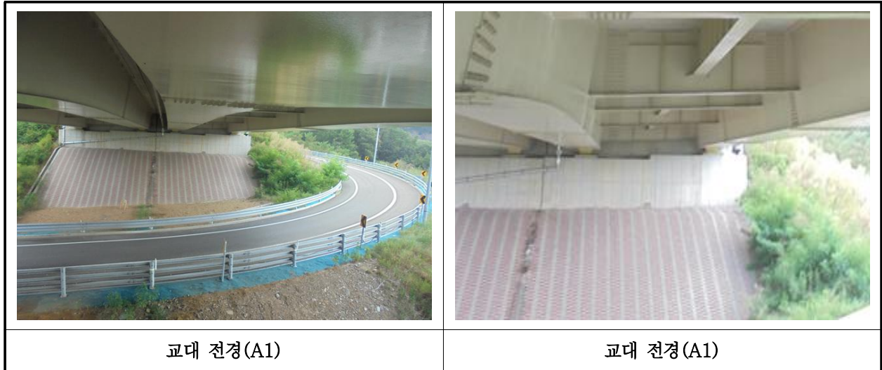
【사진 40.3.8】 교대 전경
