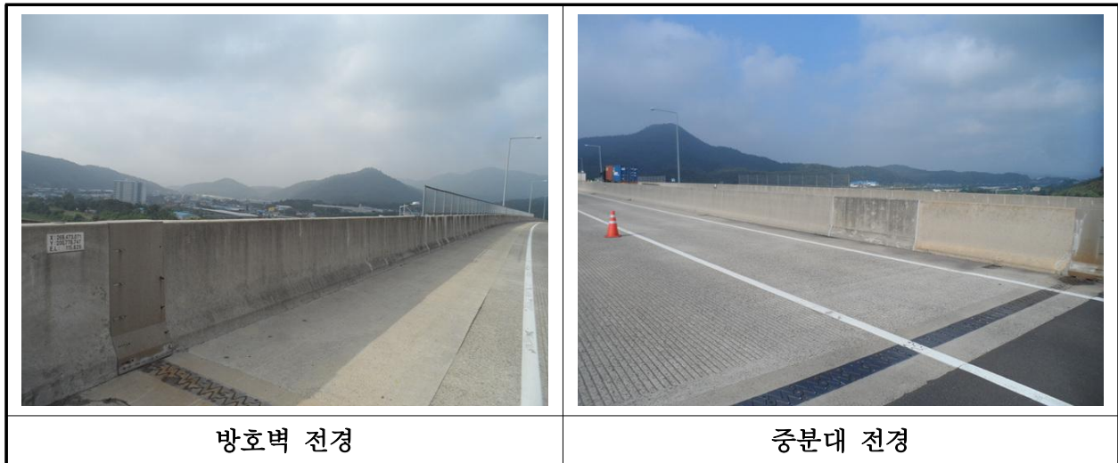
【사진 40.3.23】 방호벽 및 중분대 전경
