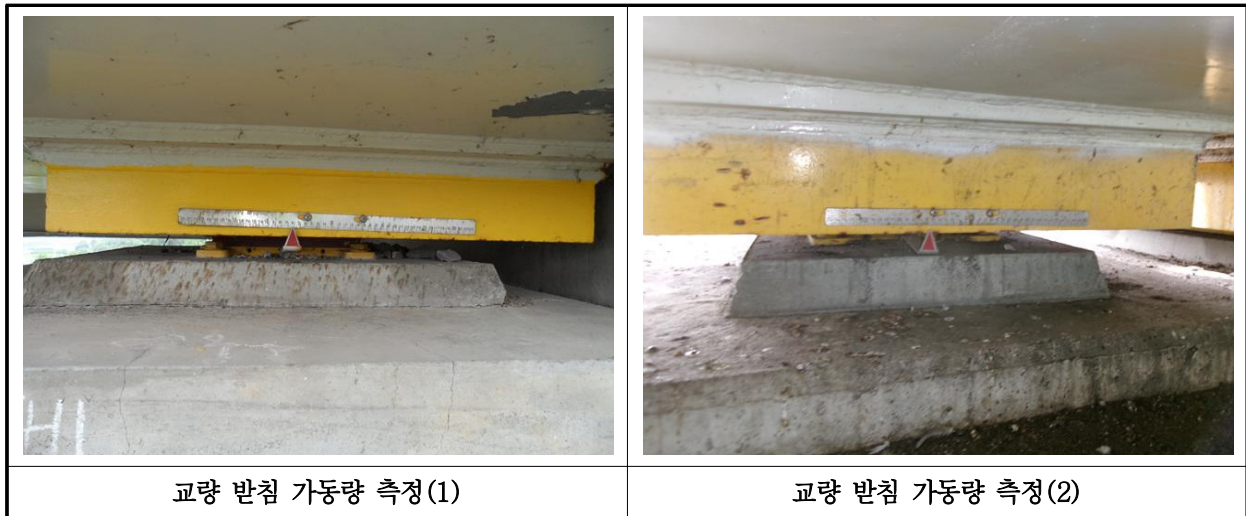
【사진 40.3.15】 교량받침 이동량 측정
