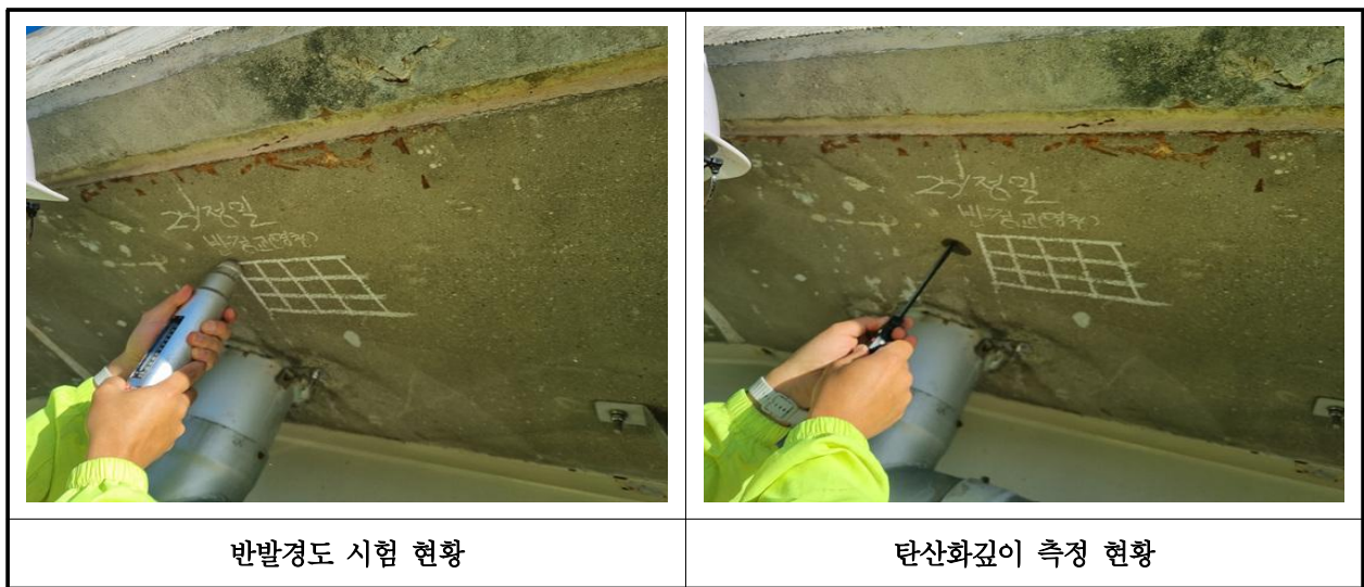
【사진 40.4.1】 콘크리트 내구성조사 현황
