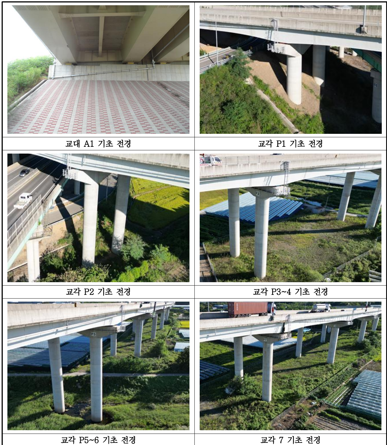
【사진 40.3.37】 기초 전경
