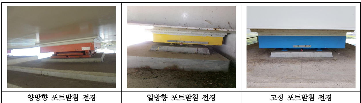
【사진 40.3.38】 교량반침 전경
